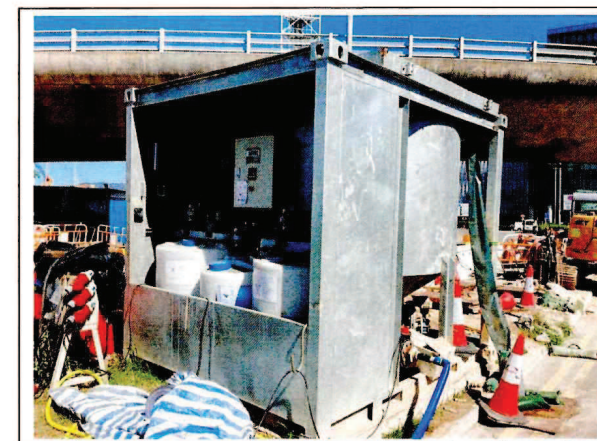
Wastewater treatment plant 污水處理器
